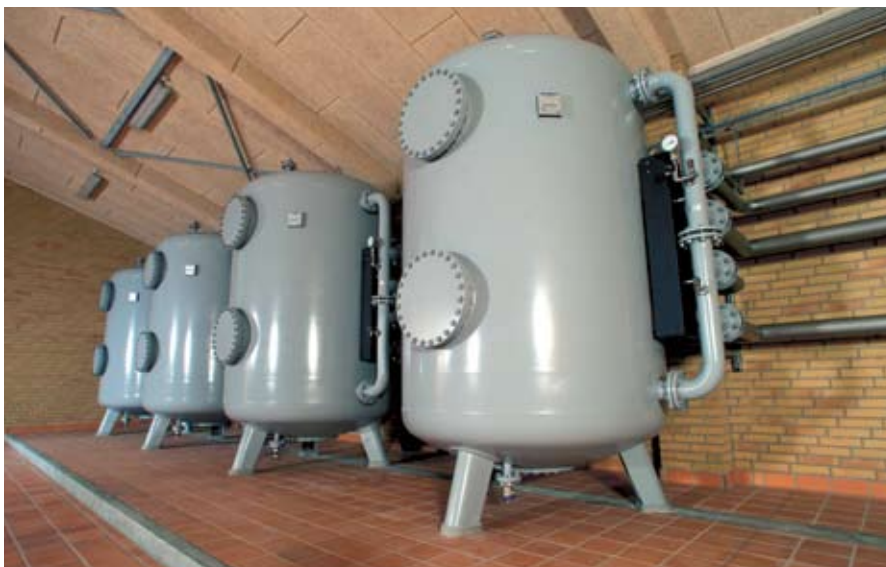
Udvidelse af forsyningskapaciteten hos Skærbæk Vandværk.
