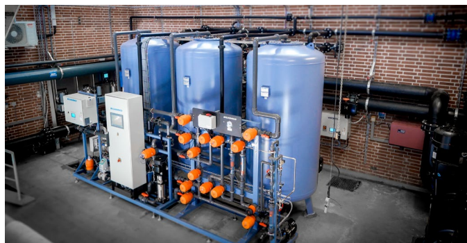
Blødgøring af drikkevand ved hjælp af ionbytnings teknologi hos TÅRNBYFORSYNING Vand.
